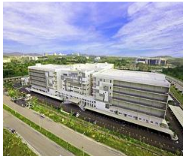
CSF 社 データセンター
